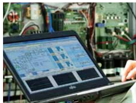
Supporto alla messa in servizio
